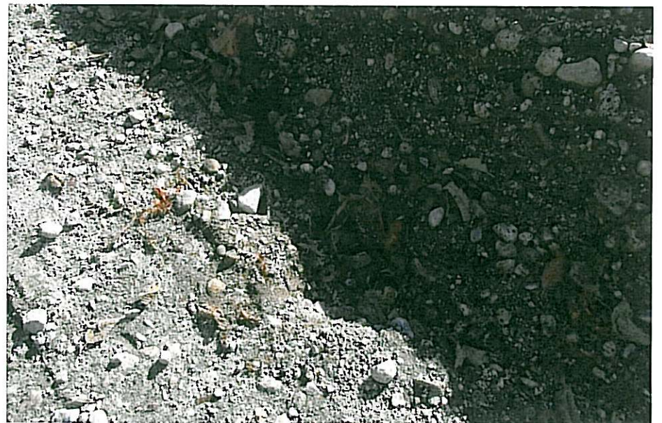
CK-2262 Gravel Fill
